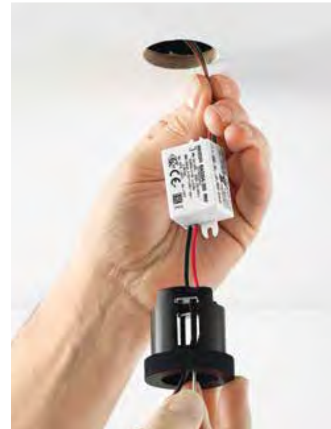
Montage RENDEL 28 mit Mini-LED-Treiber.
