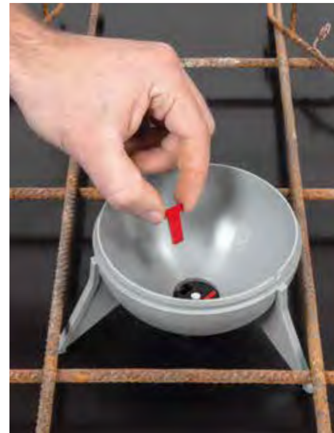
Die Sperrstifte verhindern das Aufschwimmen der Kapsel.
